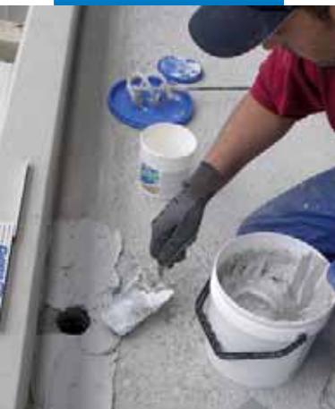
Auftragen von Adesilex PG4 auf den Untergrund
