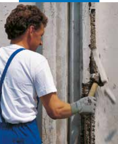
Abbruch von geschädigtem Beton
