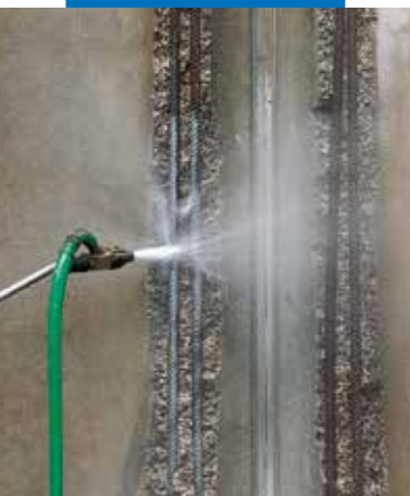
Reinigung der Bewehrung
