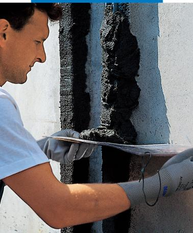
Abziehen des Mörtels mit einer Schablone
