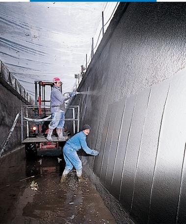
Glätten mit einer Kelle: Kanal des Wasserkraftwerks Bertini in Robbiate (Como, Italien)
