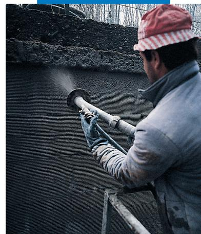
Verarbeitung im Spritzverfahren: Kanal des Wasserkraftwerks Bertini in Robbiate (Como, Italien)
