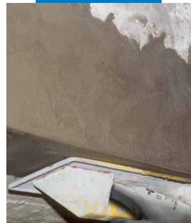
Instandsetzungsarbeiten an einem Betonträger
