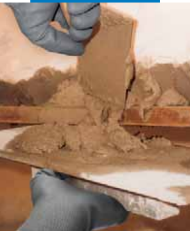
Instandsetzung einer Balkonbrüstung: Einbringen des Mörtels
