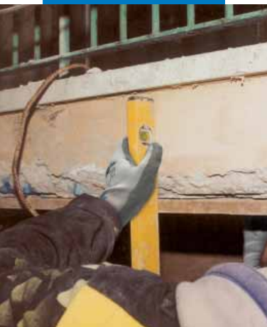
Instandsetzung einer Balkonbrüstung: Berechnung der Mörtelmenge
